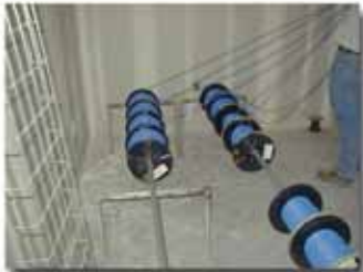
Cat 5e Pulled
